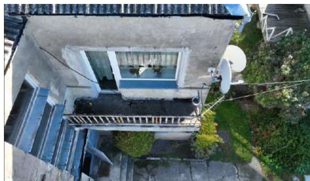
5 pav. „Balkono vaizdas“
